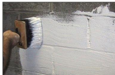
Le matériau ne doit pas être étalé de manière excessive ; il est nécessaire d'appliquer une couche optimale afin d'obtenir une meilleure imperméabilisation. L'application doit comporter un minimum de 2 couches.
